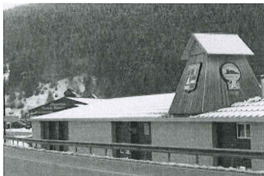
Installation d'un tuyé dans un atelier de transformation
