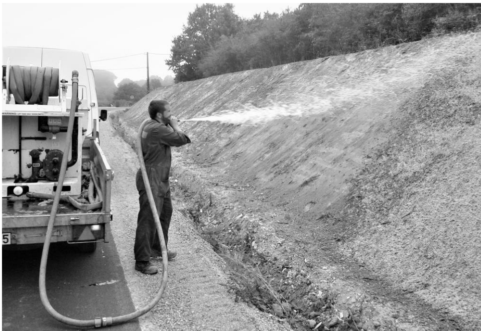
Ensemencement par hydroseeder (projection hydraulique). Source professionnelle.
