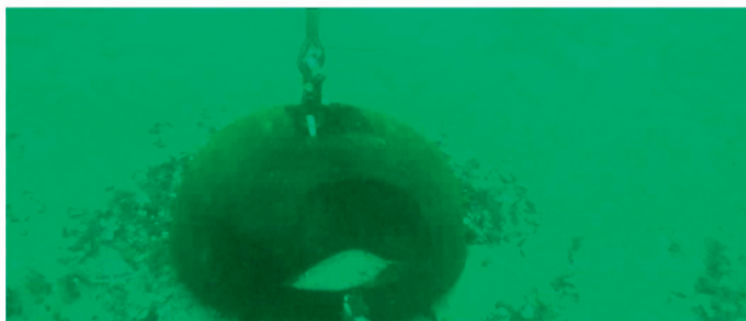
Corps-mort en fonte circulaire (ETM)
